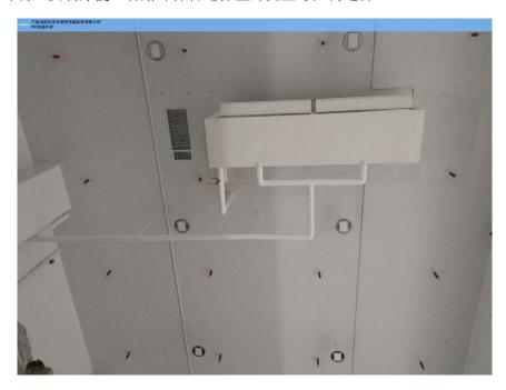
PVC彩色保温外壳,是一种特种的复合材料,产品预制成型,便于安装,是一种整洁统一、干净美观的,可以适用于各种管道及设备的外保护及其保温外包外壳的系统。
